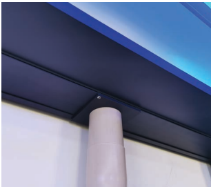
INTÉGRATION DE DESCENTE D'EAU PLUVIALE Intégration des gouttières déjà existantes. Sur étude de faisabilité.
